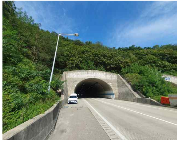
5공구 중구터널(영천) (5공구) 종점부
