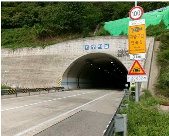
5공구 효령터널(상주방향) (5공구) 시점부
