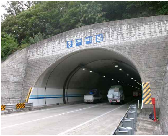
5공구 중구터널(영천) (5공구) 시점부
