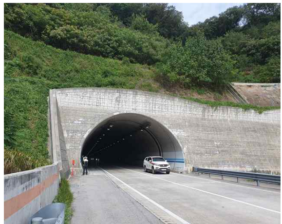
5공구 효령터널(영천방향) (5공구) 종점부
