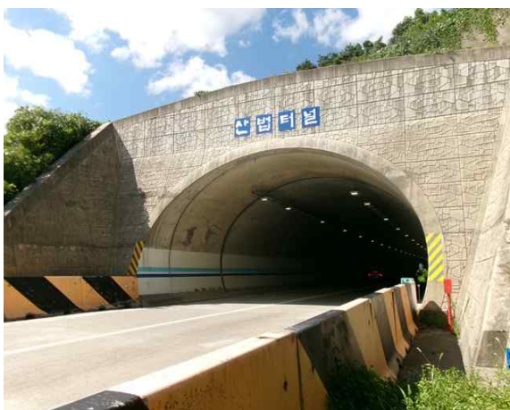
4공구 산법터널(상주방향) (4공구) 시점부
