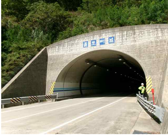
5공구 불로터널(상주) (5공구) 시점부
