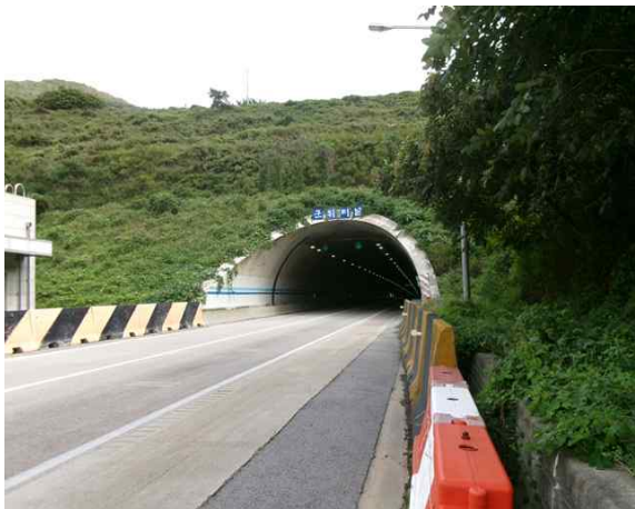
3공구 군위터널(영천방향) (3공구) 시점부
