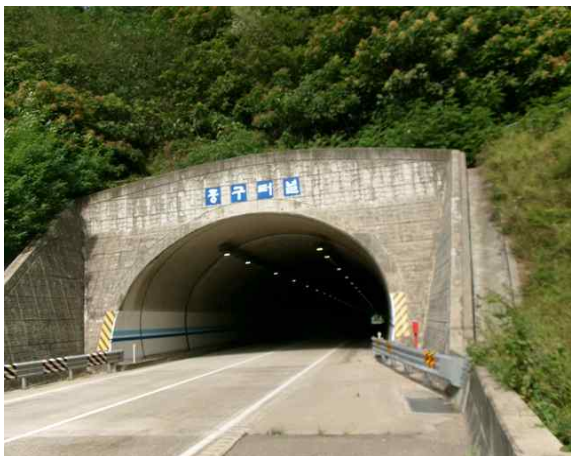
5공구 중구터널(상주) (5공구) 시점부
