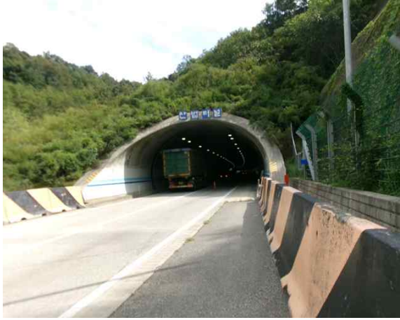
4공구 산법터널(영천방향) (4공구) 시점부
