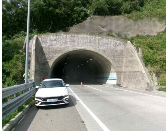
4공구 산법터널(영천방향) (4공구) 종점부
