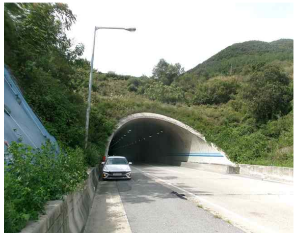
3공구 군위터널(영천방향) (3공구) 종점부
