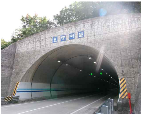
5공구 효령터널(영천방향) (5공구) 시점부
