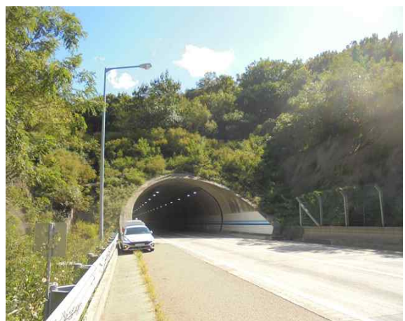
4공구 산법터널(상주방향) (4공구) 종점부
