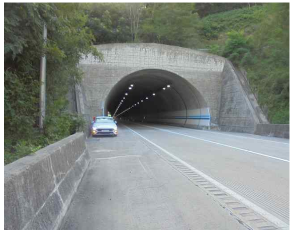
5공구 효령터널(상주방향) (5공구) 종점부
