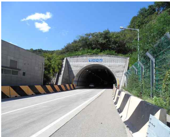
4공구 평호터널(상주방향) (4공구) 시점부
