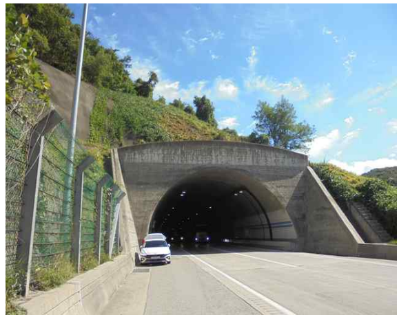
4공구 평호터널(상주방향) (4공구) 종점부
