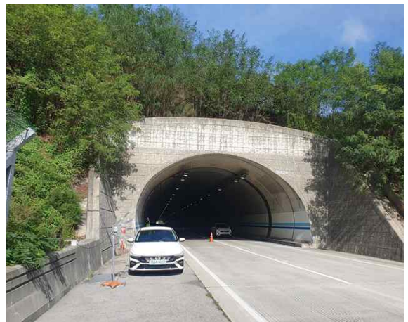
5공구 불로터널(영천) (5공구) 종점부
