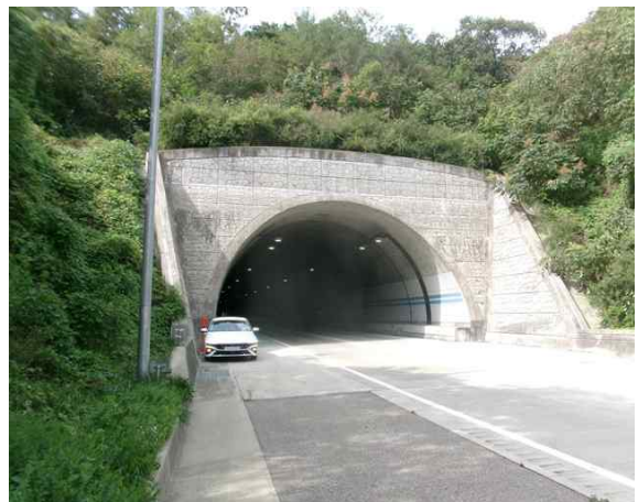
4공구 평호터널(영천방향) (4공구) 종점부
