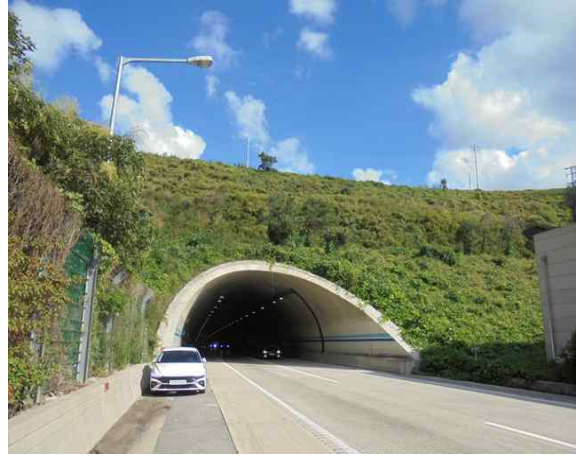
3공구 군위터널(상주방향) (3공구) 종점부
