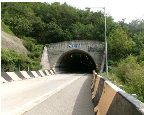
4공구 평호터널(영천방향) (4공구) 시점부
