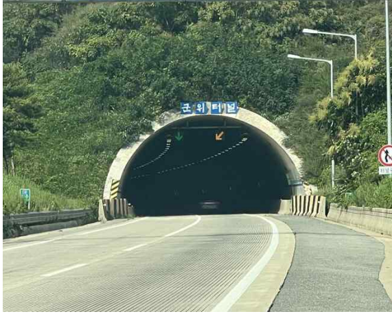
3공구 군위터널(상주방향) (3공구) 시점부
