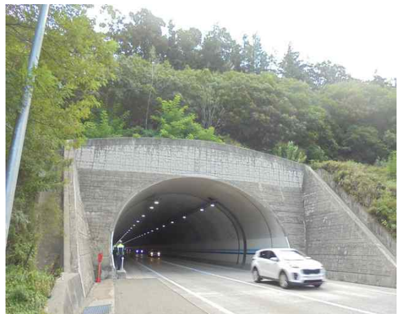
5공구 중구터널(상주) (5공구) 종점부
