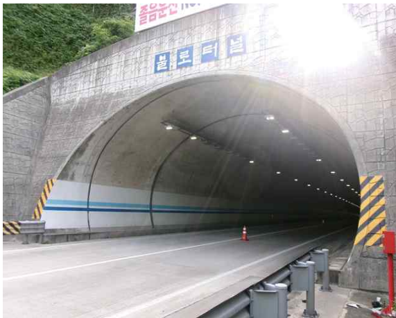
5공구 불로터널(영천) (5공구) 시점부
