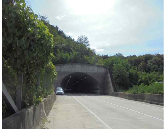
5공구 불로터널(상주) (5공구) 종점부
